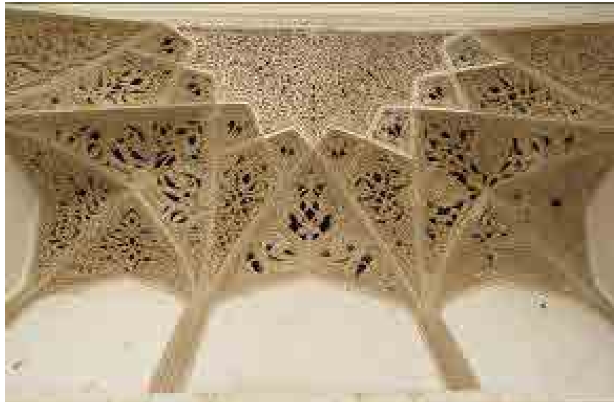
تصویر ۱۰. دهانه‌ی خروجی بادگیر با تزئینات مشبک گچبری (نگارندگان، ۱۳۹۳). ◀
