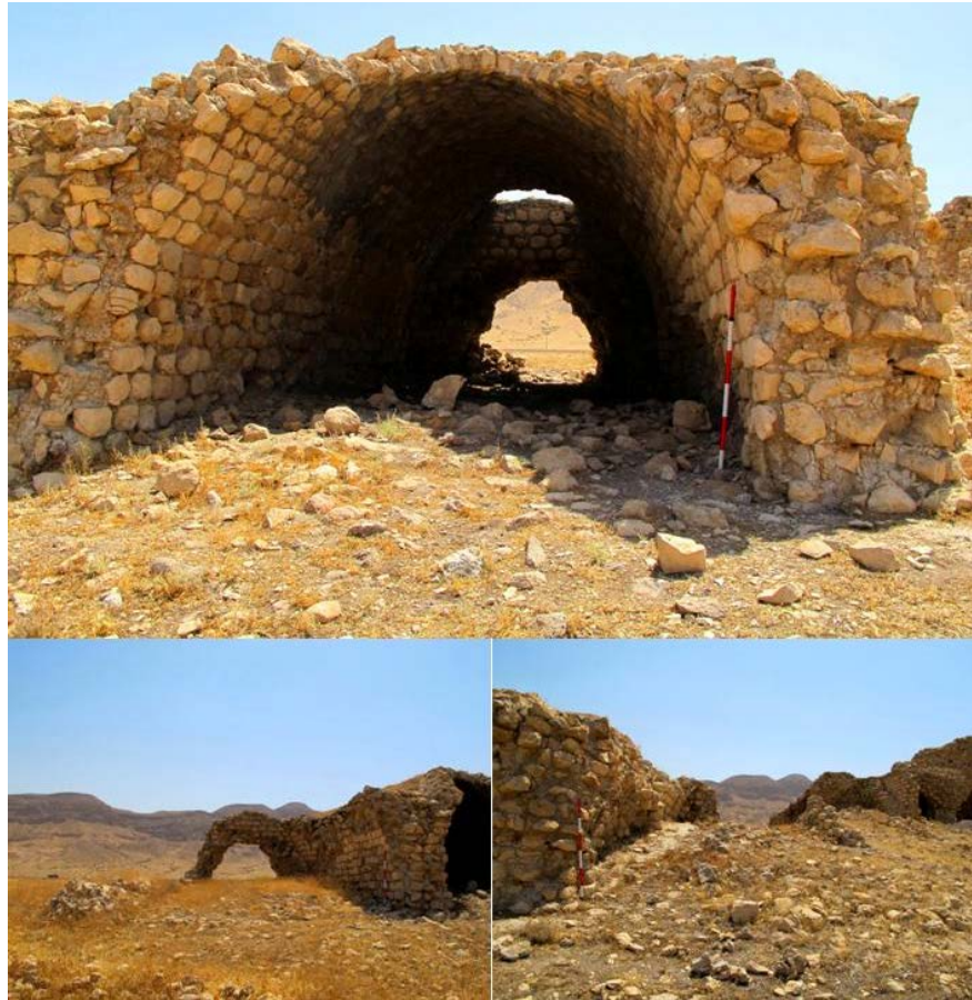
► تصویر ۱۰. اتاق‌های بخش جنوب‌غربی که نشان‌دهنده‌ی طاق‌ها و بخشی از تخریب بنا می‌باشند (نگارندگان، ۱۳۹۱).
