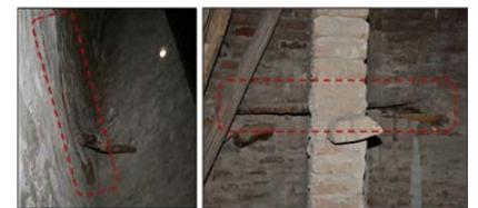
▲ شکل ۱۲. وجود کلاف مداری در پوسته‌ی بیرونی گنبد افوشته‌ی نطنز (نگارندگان، ۱۳۹۴).
