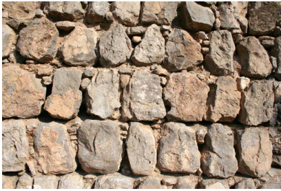
▲ تصویر ۴. نحوه سنگ‌چینی دیوار جنوبی بنای تاریخی سرماج (نگارنده، ۱۳۸۵).
