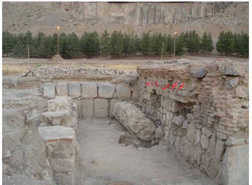
▲ تصویر ۱۴. ریزش سقف در اتاق شماره‌ی ۳۵ (دید از جنوب) و نقشه‌ی کاروانسرای ایلخانی (نگارندگان، ۱۳۹۱).
