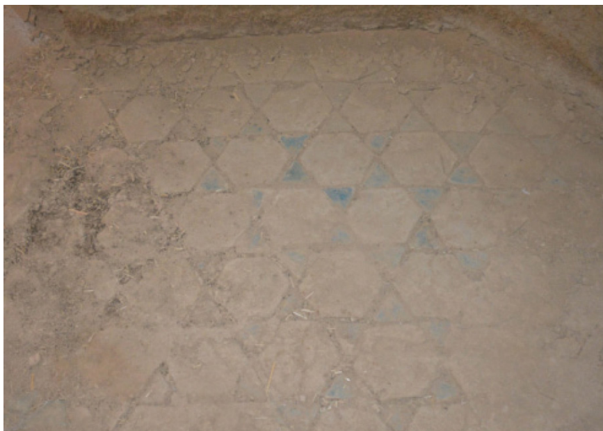
شکل ۱۹. ترکیب آجر شش ضلعی و کاشی در طنبی خانه برونی میبد (میردهقان، ۱۳۹۵: ۱۱۳).
