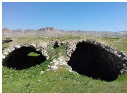
تصویر ۸. نمونه‌های از طاق‌های آهنگ با چفد هلوچین کند زاغه (نگارندگان، ۱۳۹۹). ◀
