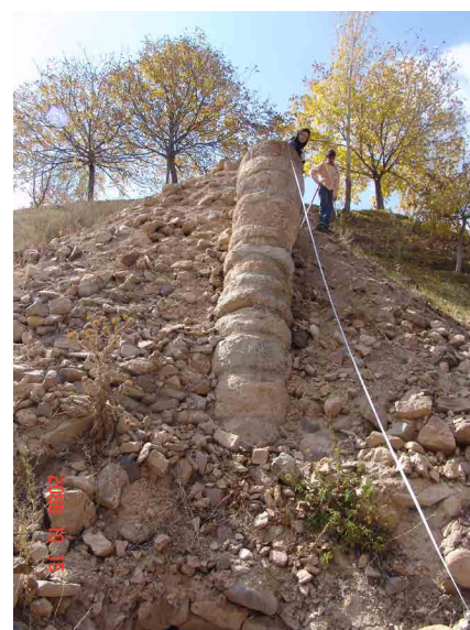
تصویر ۱۲: آسیاب گرماب: تنوره آسیاب ساخته شده با حلقه‌های سنگی و ساروج (نگارنده، ۱۳۸۸).
