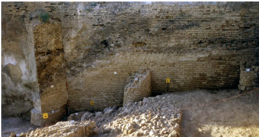
تصویر ۱۶. پشت‌بندهای مدور دوره حسنیویه و مثلثی شکل دوره صفوی در نمای شمال غربی پل (عکس از: نگارنده، ۱۳۸۱).
