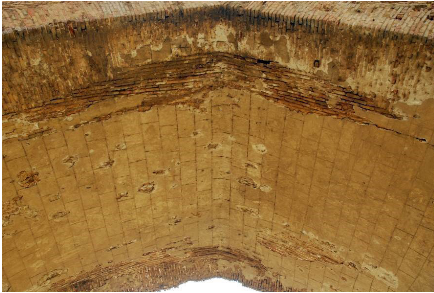
تصویر ۱۵. اندود آهک دوره پهلوی اول بر روی طاق دهانه ششم (عکس از: نگارنده، ۱۳۸۱).
