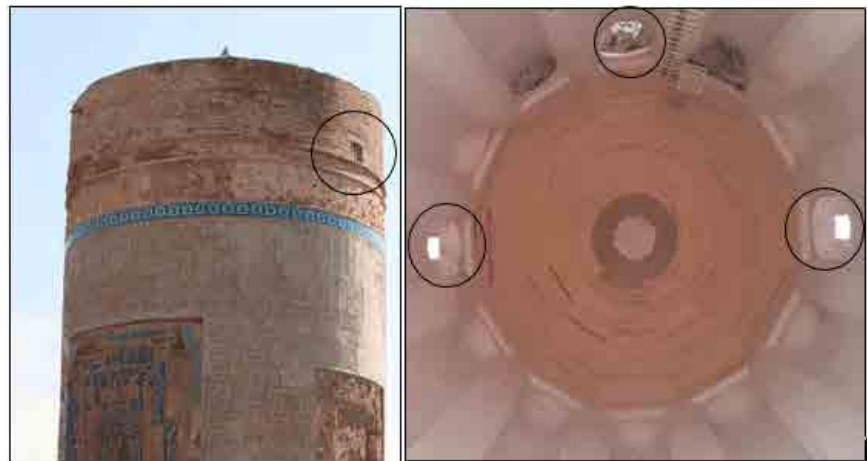
► شکل ۶. نمای داخلی برج مقبره شیخ حیدر و روزه‌های به‌کاررفته در بدنه برج (نگارندگان، ۱۴۰۰).
