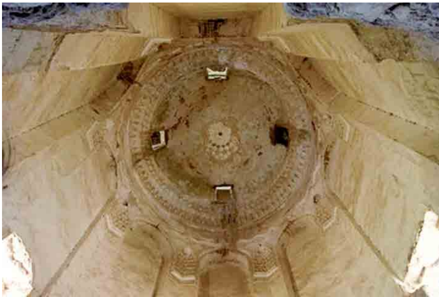
شکل ۲۲. نمای داخلی برج مقبره زینال بیک و آرایه‌های مقرنس گچی آن (Mansouri & Caghan keskin, 2012: 367).
