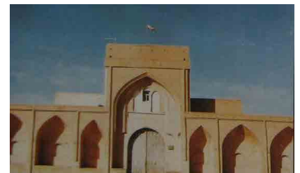
▲ تصویر ۱۱: نمای ایوان ورودی به حیاط دوم، پیش از تخریب بنا (دانشدوست، ۱۳۷۶: ۴۳۷). Fig. 11: The view of the entrance porch to the second courtyard, before the destruction of the building (Daneshdoost, 1997: 437).
