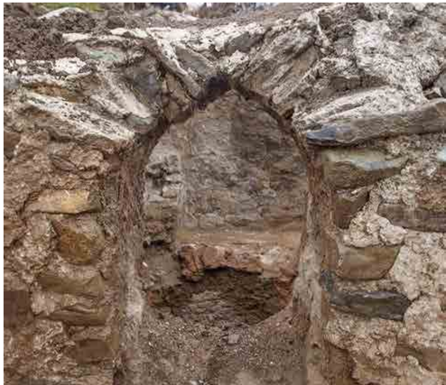
► تصویر ۱۲. درگاه ورودی (نعمتی، ۱۳۹۷). Fig. 12. Entrance Gate (Ne`mati, 1397).
