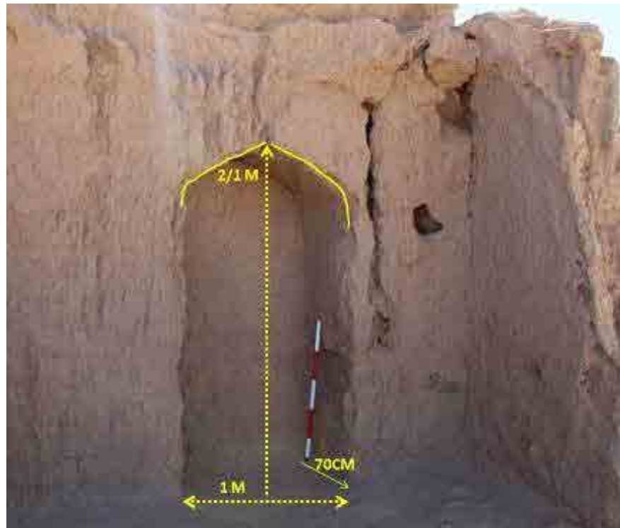
► تصویر ۲۶: نوع تاق درگاه مسدود شده شبستان غرب ایوان جنوبی (نگارندگان، ۱۳۹۷). Fig. 26: Arch of a blocked doorway, western Shabestan in southern Iran (Authors, 2019).
