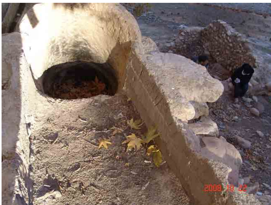
تصویر ۱۰: آسیاب استاد: مسیر سکوی فشار روباز، تنوره آب و بقایای اتاق آسیاب (نگارنده، ۱۳۸۸). ◀
