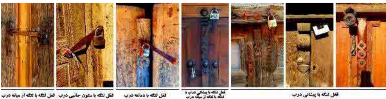
▲ تصویر ۱۱: بررسی انواع قفل‌های خارجی درب‌های سنتی ماسوله (نگارندگان، ۱۴۰۲). Fig. 11: Examining the types of external locks of traditional Masouleh doors (Authors, 2023).
