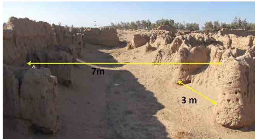
► تصویر ۶: دالان اصطبل و دیوارک‌های تقسیم‌کننده واحدها (نگارندگان، ۱۳۹۷). Fig. 6: Stable corridor and dividing walls of the units (Authors, 2017).
