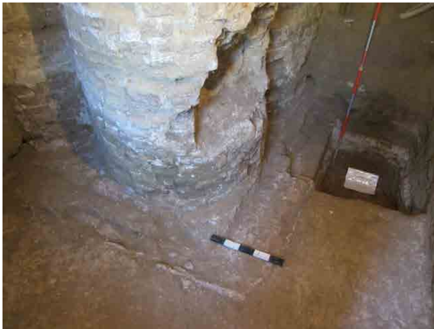
شکل ۱۲: جزئیات شالوده، بدنه ستون و کف گچی چهارطاقی فردقان (نگارندگان، ۱۳۸۷). Fig. 12: Details of the foundation, the body of the column and the plaster floor of four arches Fardghan (Authors, 2018).
