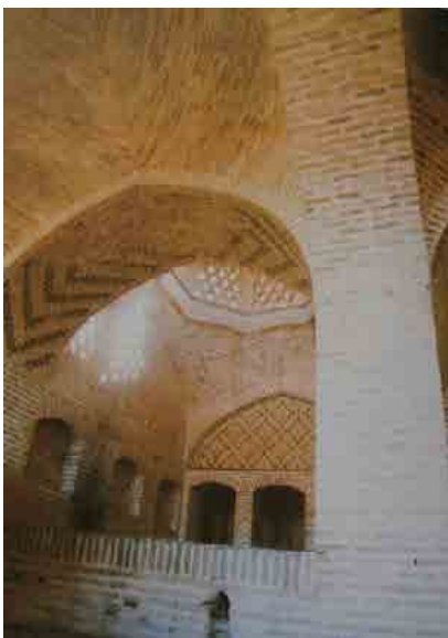
▲ تصویر ۲۰: بادگیر در انتهای دیواره ایوان شاه‌نشین کاروانسرای خان طبس (دانشدوست، ۱۳۷۶: ۴۹۳). Fig. 20: Windward at the end of the wall of the Ivan Shahneshtin caravanserai of Khan Tabas (Daneshdoost, 1997: 493).
