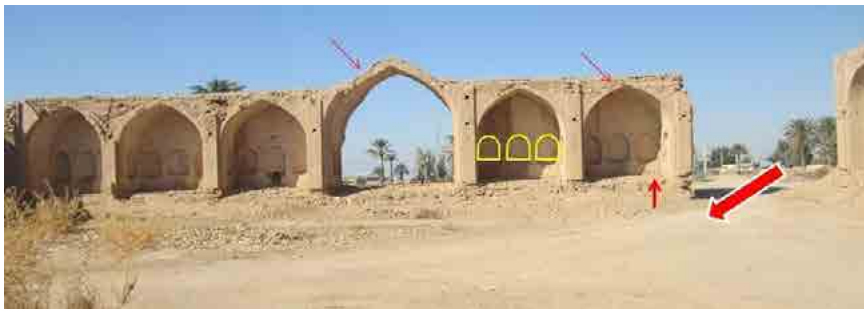
تصویر ۱۰: قرارگیری صفه‌ها در طرفین ایوان ضلع شمالی کاروانسرای جوخواه (نگارندگان، ۱۳۹۷). Fig. 10: Placement of rows on the sides of the porch on the north side of Jokhah Caravanserai (Authors, 2017).
