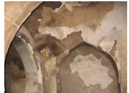
▲ تصویر ۱۰: دیوار زیارتگاه قبل از آتش‌سوزی (آرشیو میراث فرهنگی کاشان، ۱۳۸۵).
