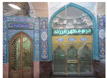
▲ تصویر ۲: درب‌های زیارتگاه بعد از آتش‌سوزی (آرشبو: قربانی‌ا قدم، ۱۳۹۷).
