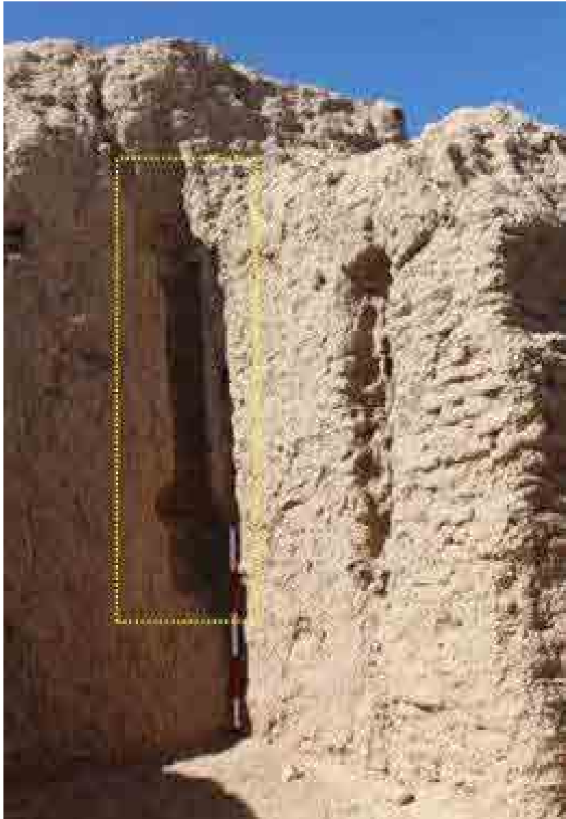
تصویر ۳۴: کاربرد ناودان سفالی دیوار بیرونی شبستان متصل به ورودی و جداافتادگی دیوارها (نگارندگان، ۱۳۹۷).
