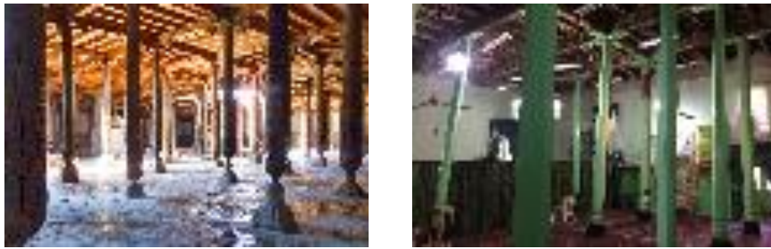
تصویر ۱۸: پا ستون، ستون، سرستون و تیرریزی در مسجد جامع ازغد (راست)، (نگارندگان، ۱۴۰۰) و مسجد جامع خیوه (چپ)، (بلالی اسکویی و آشتیانی، ۱۳۹۹). Fig. 18: Wooden Structural System of the Jameh Mosque of Azghad and the Jameh Mosque of Khiva (Belali Oskoui & Ashtiani, 2020).
